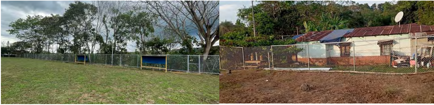
Figura 09. Instalación de cerramiento en malla ciclón.
