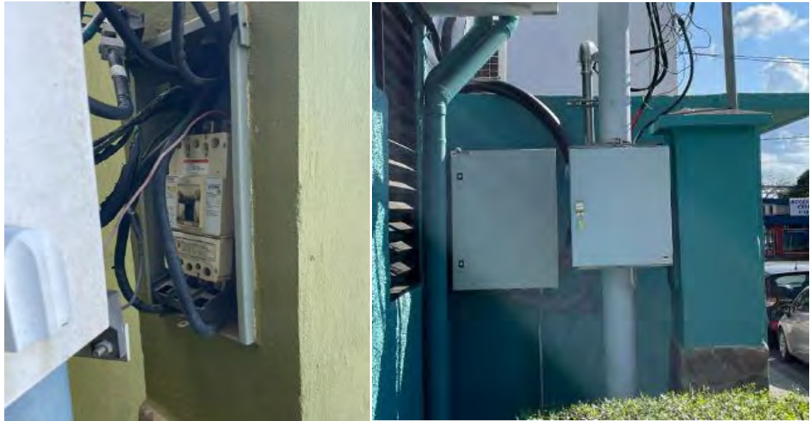
Figura 11. Sustitución de interruptor principal.
