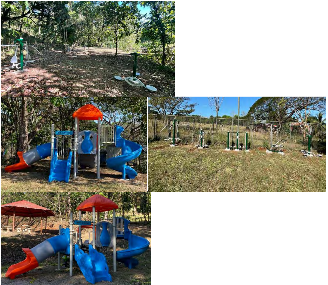
Figura 07. Instalación de playground y máquinas saludables.
