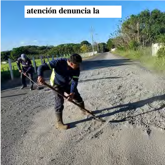
Reacondicionamiento de superficie y cunetas en el Guácimo calle Malinches
