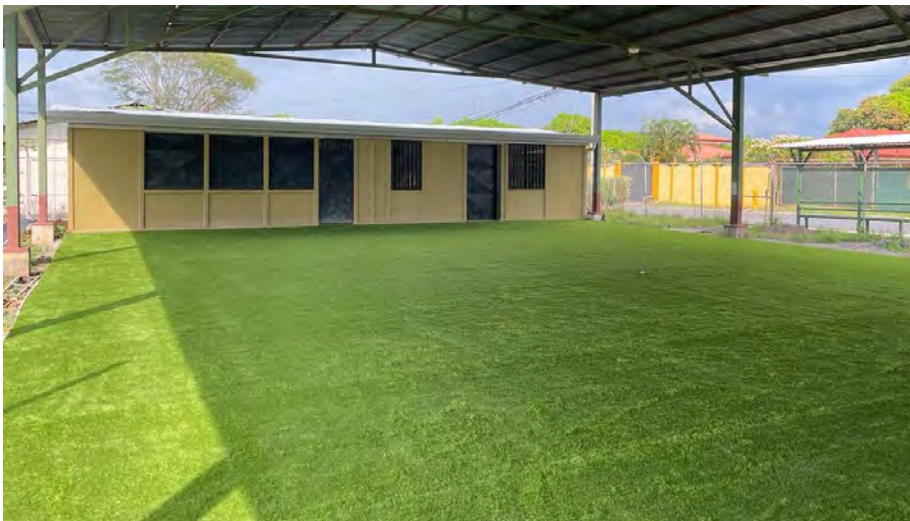
Figura 10. Instalación de césped sintético.
