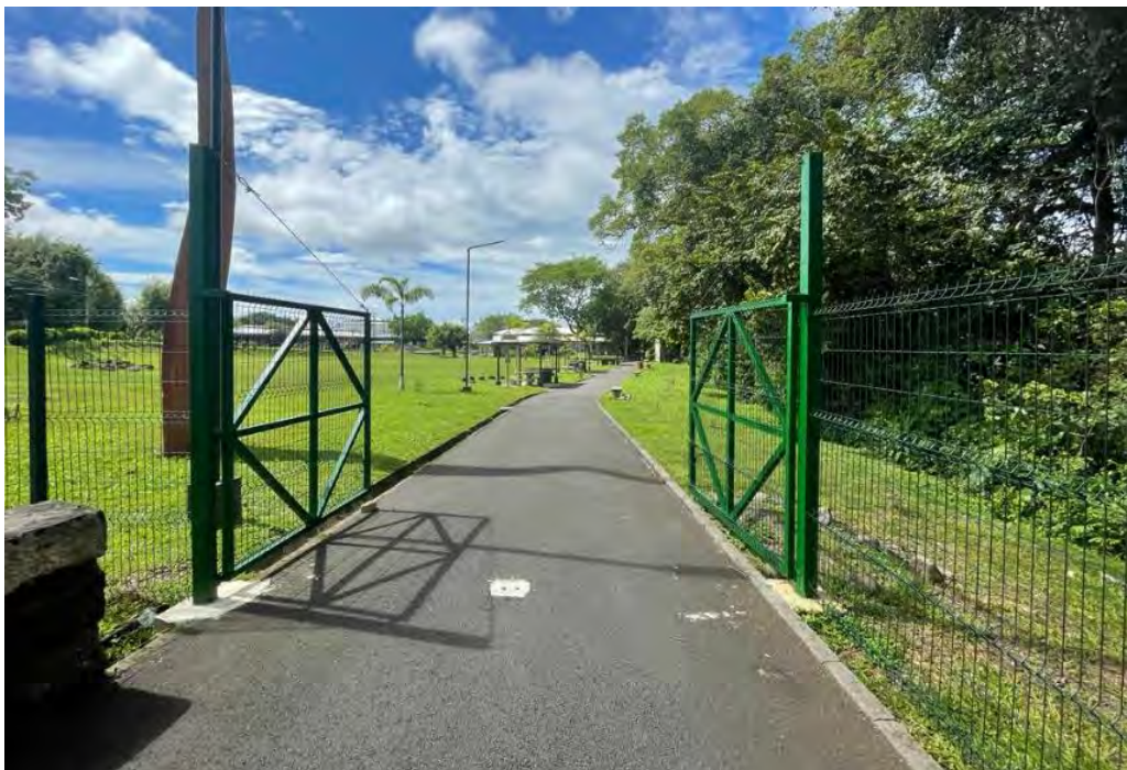
Figura 02. Instalación de malla perimetral en NARIME.
