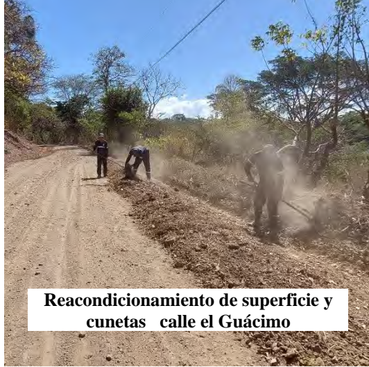
Reacondicionamiento de superficie y cunetas calle el Guácimo
