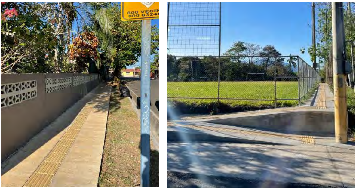
Figura 04. Estado de aceras después de la intervención.
