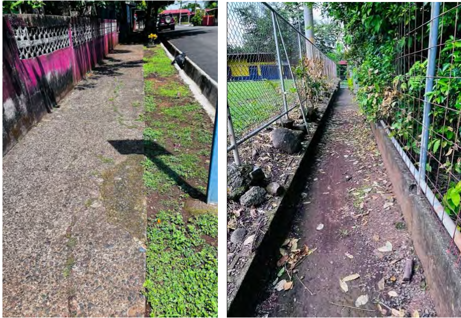
Figura 03. Estado de aceras antes de la intervención.
