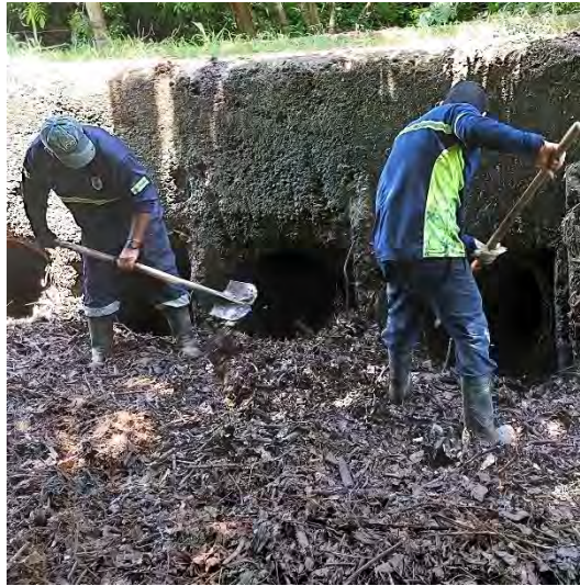
Lagunillas Calle al Tajo, limpieza del vado
